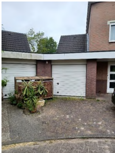
Foto voorzijde, tussen garages mogelijk aanvoer warmteleiding.
