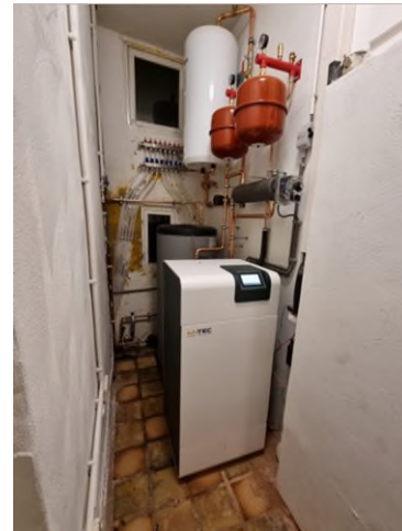
Figuur 5-1: Water/Water-warmtepomp installatie binnenshuis (bron: Indurio)
