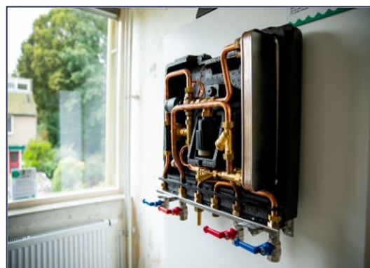
Figuur 5-2: Afleverset bij een MT-warmtenet
