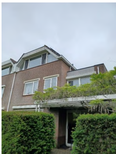
Achterzijde van woning met zicht op ketelruimte.
