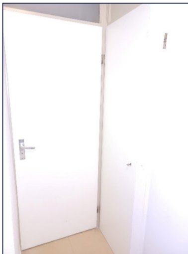
Deur links toilet, deur rechts meterkast
