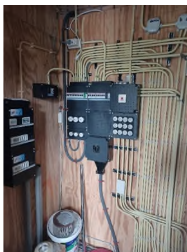
Hoofdverdeler van het complex. Voor VvE 3 x 80A, voor appartementen 3 x 160 A (foto links) Centrale meterkast van complex (foto rechts).
