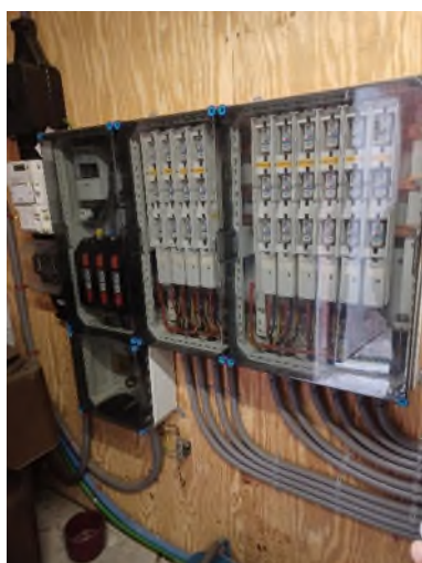
Hoofdverdeler van het complex. Voor VvE 3 x 80A, voor appartementen 3 x 160 A (foto links) Centrale meterkast van complex (foto rechts).
