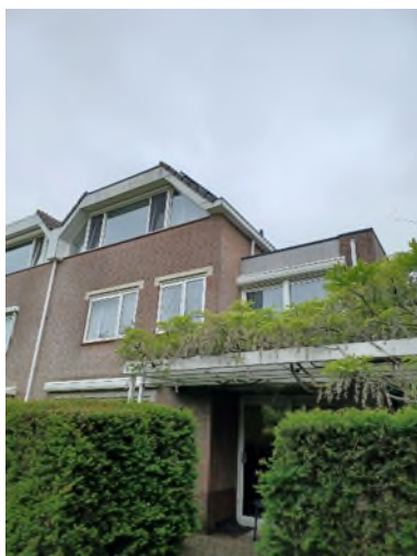
Achterzijde van woning met zicht op ketelruimte.
